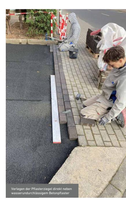
von rund 50 m² als Demonstrationsfläche mit wasserdurchlässigen Pflasterziegeln gepflastert. Die mit diesem Ziegel befestigten Flächen sind bequem begehbar, haben keinen Unkrautwuchs, keine Ausspülungen nach Starkregenereignissen und sind rutschfest – selbst bei Regen.
